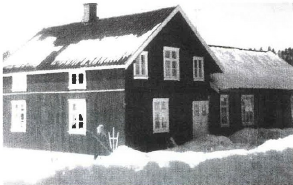
Folkets hus i Gjevelsrudveien var IL Driv sitt samlingssted fra stiftelsen i 1937 til huset ble solgt i 1968. Bygningen står fortsatt, men er idag i privat eie. Foto: Privat.
