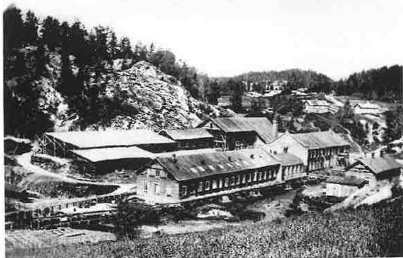
Etter brannen i 1870 bygde Holm Jølsen en ny og større fyrstikkfabrikk på samme sted. Dette fotografiet fra 1872 viser denne fabrikk. I 1875 brant også denne fabrikk ned. Foto: Enebakk historielags arkiv.
