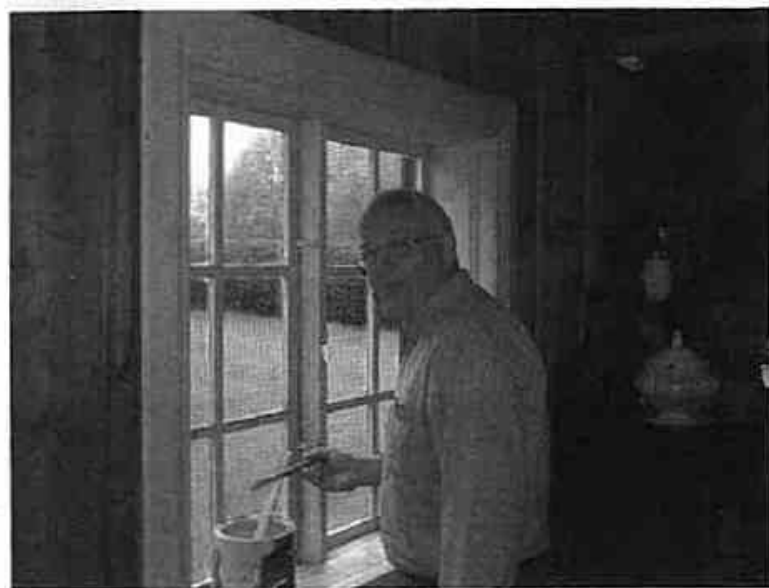
Vinduer og vinduskarmer fikk nytt strøk.
