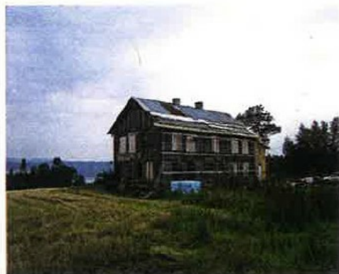
Ringstad gård er en svært gammel gård. Den flotte hovedbygningen er under restaurering.
