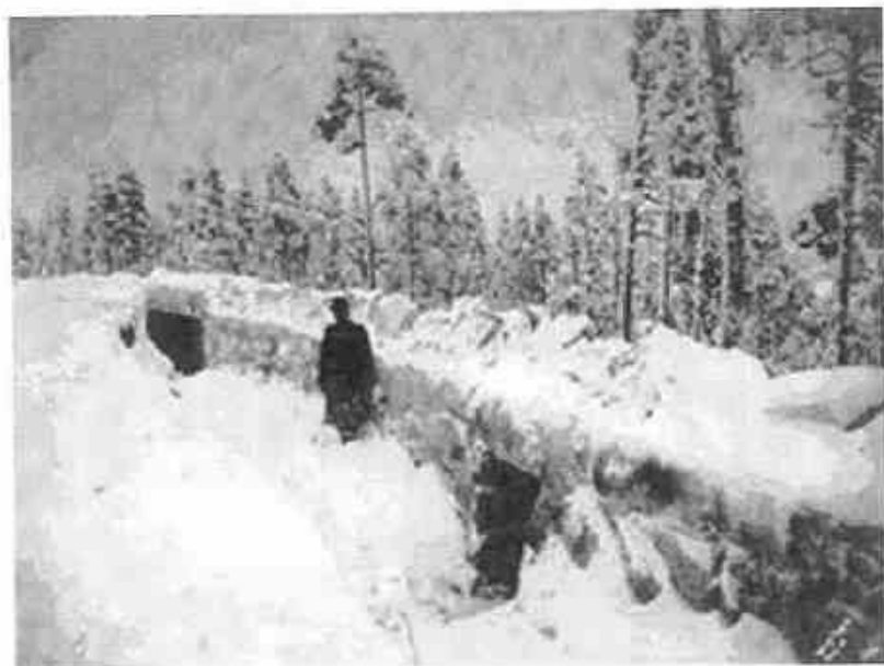
Bildet viser skyttergraven på Urskog fort. Det er lagt opp stein til skyteskår og det går en underjordisk gang ut til kaponierbygningen i fronten. (Kilde: Bildesamlingen FM. Foto: Wilse).
