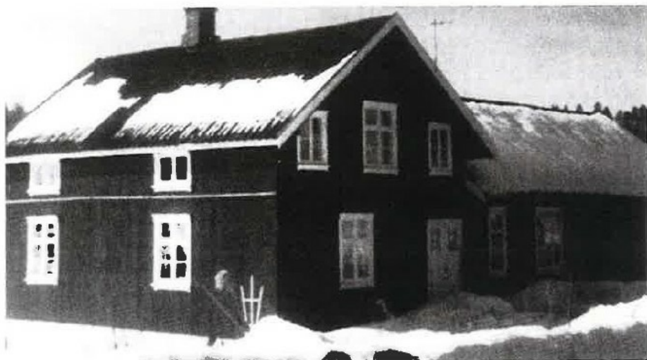
Folkets hus i Gjevelsrudkroken i Ytterbygda. Foto: Privat.
