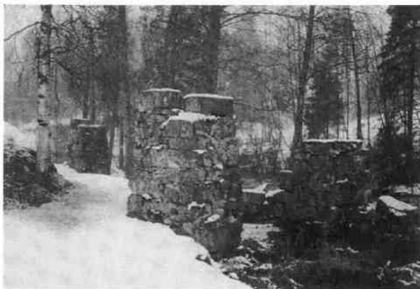
Ruinene etter den gamle saga ved Tangenelva i Ytterbygda, fotografert i 1992. Tidlig på 1990-tallet ryddet Tangenelvas venner dette området og gjorde det fremkommelig for bygdefolket. Dessverre er disse stiene og ruinene på nytt i ferd med å gro igjen. (red.) Foto: Henning Bergersen.
