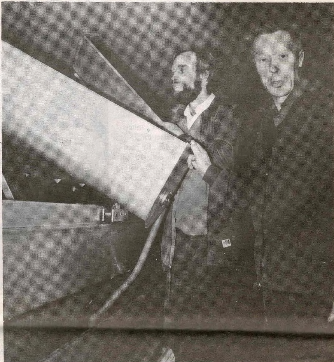
Vannverkene kan ha mye å tjene på tettere samarbeid. Hver for seg har de avanserte vannbehandlingsanlegg. Samarbeid om oppsynsfunksjonen er noe av det man nå vil se nærmere på. Her viser Johan Ellingsen og Pål Rust i Flateby Vannverk fram det flotte renseanlegget ved Gjeddevann.
