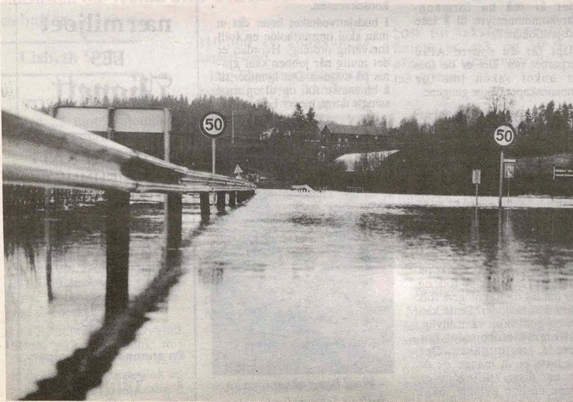
I hele fire dager var riksvei 120 ved Mjær stengt. Is og flom gjorde det livsfarlig å krysse
