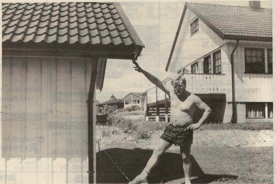
Fortsatt mangler nabosamtykke for to av de fem garasjene som ble satt opp uten byggeomelding. Flere av garasjene har takstikket langt inn på naboieiendommen.
