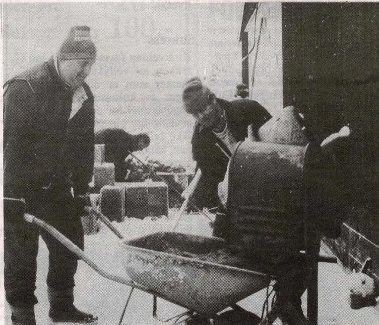
To av branngutta i sving. Om ikke lenge står garasjen klar til "vannvogna" etter iherdig dugnadsinnsats fra brannmannskapene.
