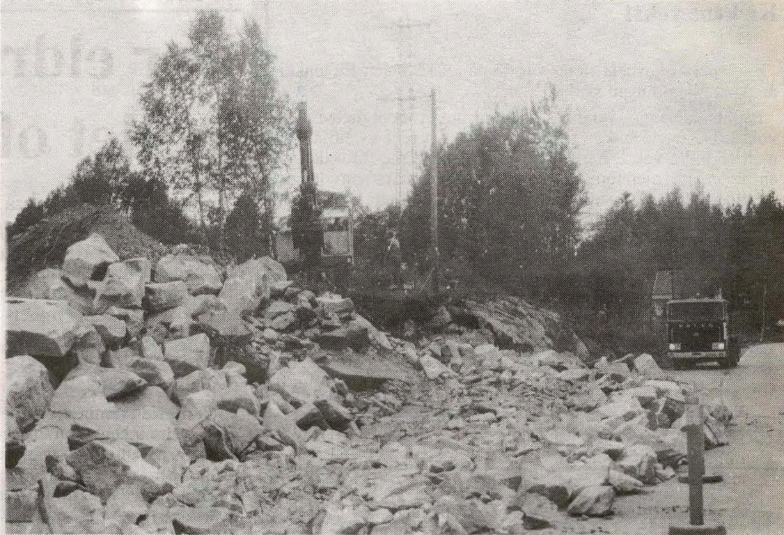
Arbeidene med legging av hovedkloakk til Råken er godt igang. Her er det sprengningsarbeider som pågår ved innkjørselen til Råkendalen.
