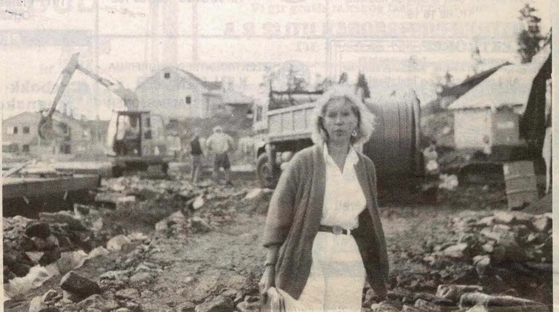
-Hele Nylende er et forsøksprosjekt, sier Jorunn Buer i styringsgruppa for selvbyggerprosjektet. -Andre felt kan bygges på samme måte, sier Buer.
