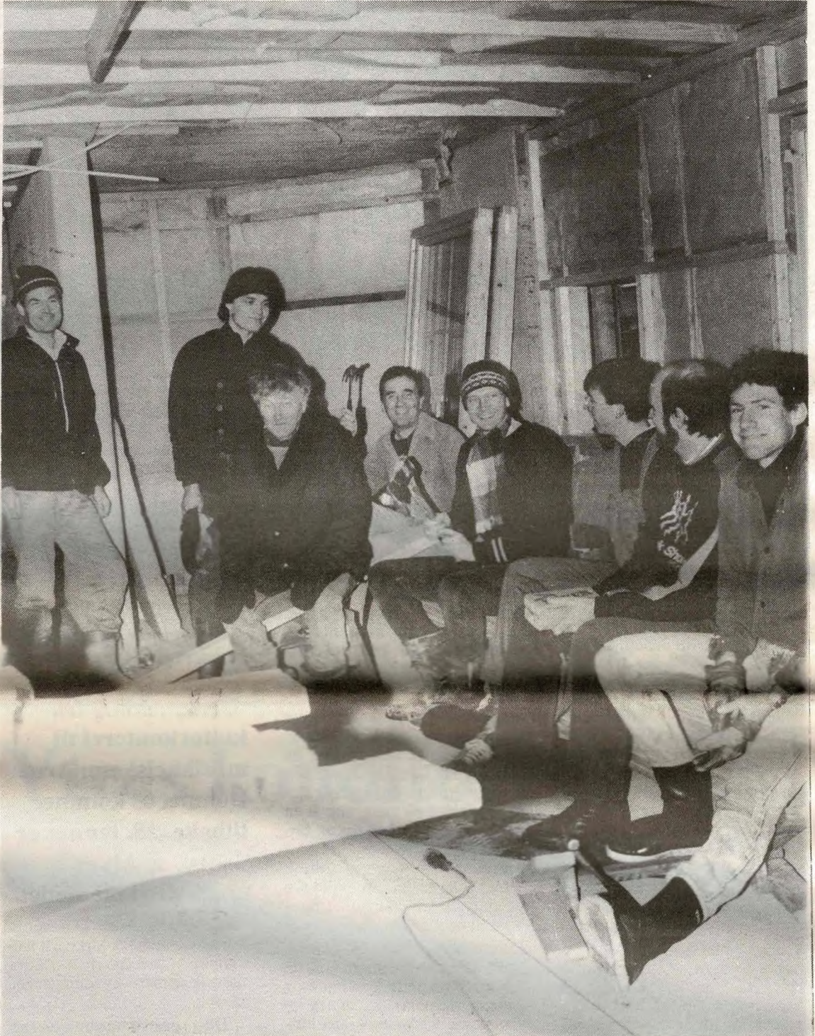
Dugnadsgjengen tar en pust på plankestabelen i et av rommene som skal huse barnehagen. Arbeidet går nå for fullt.
