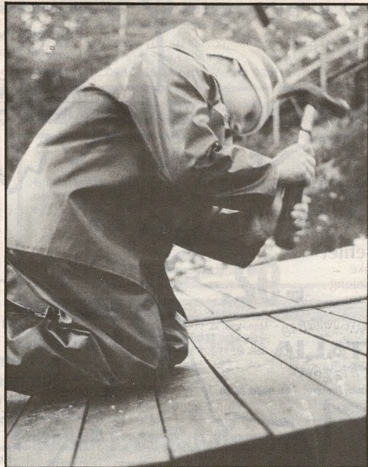
Dugnadsarbeidet gikk for fullt med reparasjoner på hoppet i den store bakken, lørdag formiddag. Her er yngstemann i dugnadsgjengen i sving med hammeren.
