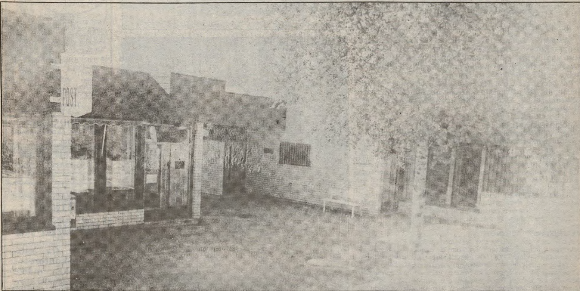
Legesenterets lokaler skal utvides med 247 kvm., og det er blant annet meningen å overta kulturkontoret og tannlegekontoret til legesenterformål.
