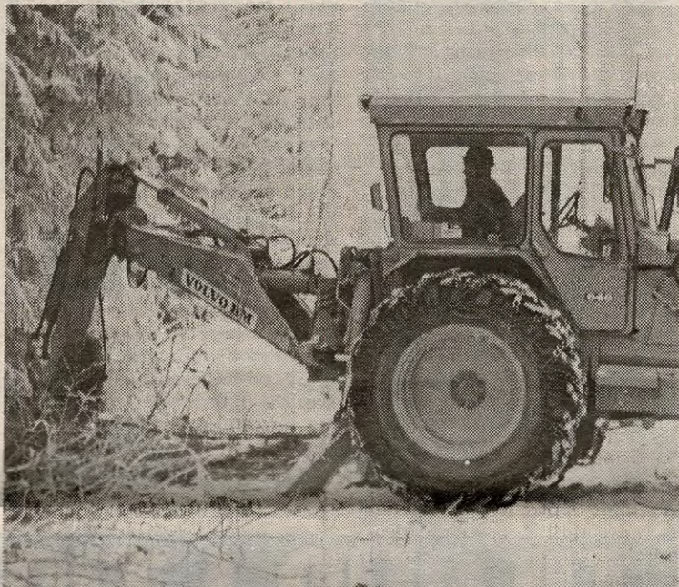
Man kom sent i gang med lysløypa fordi man måtte vente på frost så de svære maskinene kunne komme til uten å ødelegge løypa. Her jobbes det på spreng i innspurten.
