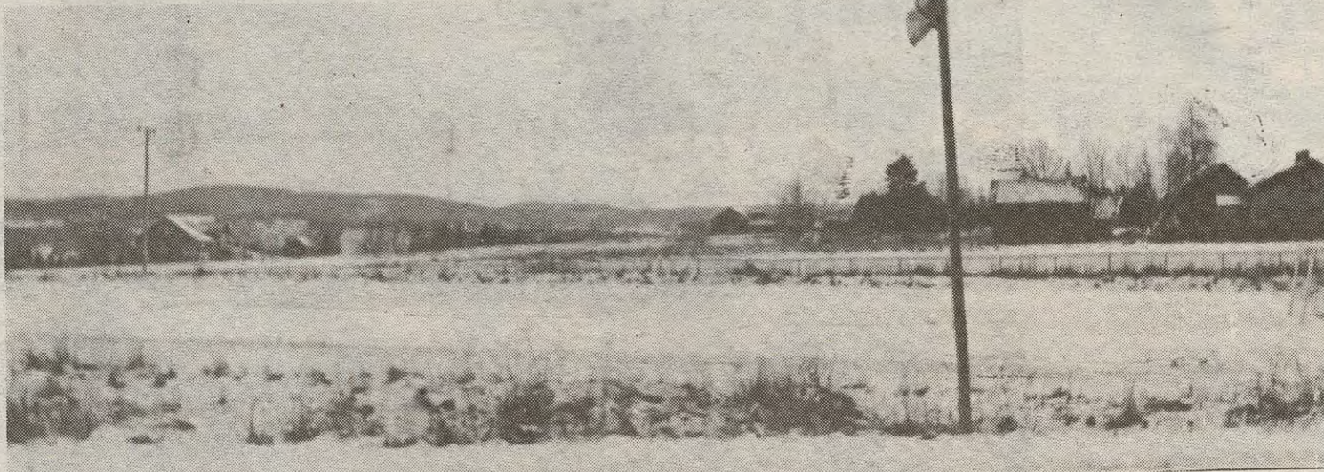
Vidotta – en totalopprusting av eksisterende anlegg ble i 1982 kalkulert til 700 000 kroner (82 pris). Plassen som den i
